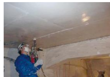
⑤ シート溶着状況
