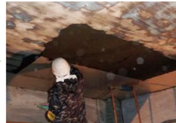
③ モルタル仕上げ状況
