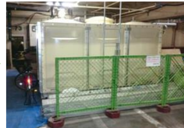
② 仮排水槽
