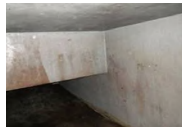
施工完了後2年経過
